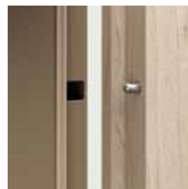
Tréne proti vysadeniu krídla – AGAT, OPAL
