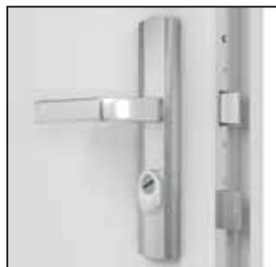
Vierpunktverriegelung, geeignet für zwei Profilzylinder
