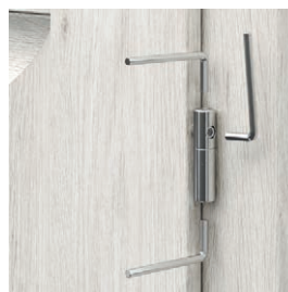
regulace nastavitelných 3D čepových závěsů
