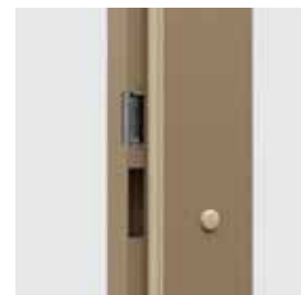
Regulovateľný protiplech zámku v kovovej zárubni (možnosť výberu)
